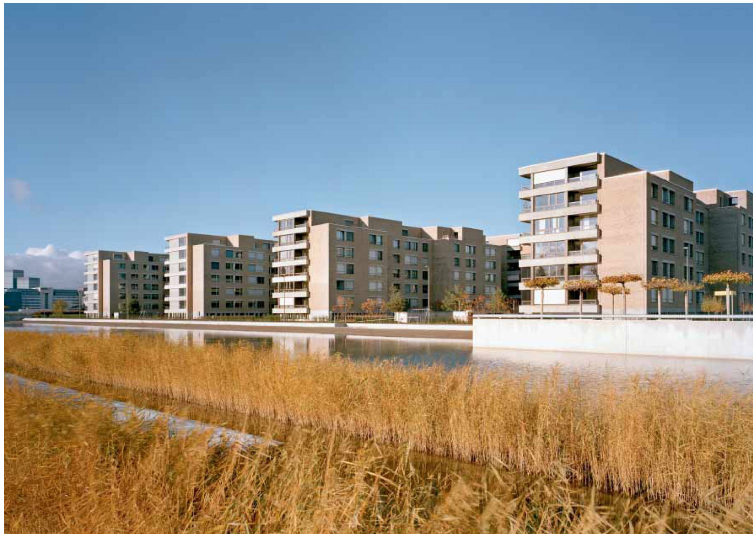
Blick vom Park aus, links die für die CS erstellten Bauten
