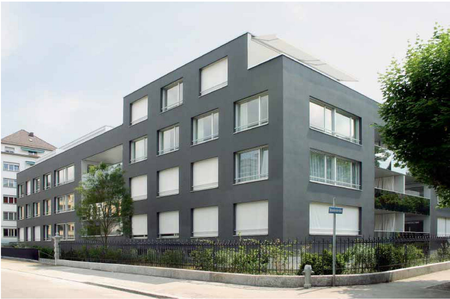
Zugang von der Strasse (Bild: Gigon/Guyer)
