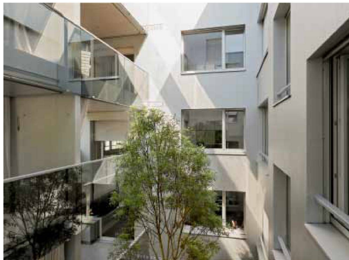
Glasbrüstungen und Silberanstrich der Hofeinschnitte
