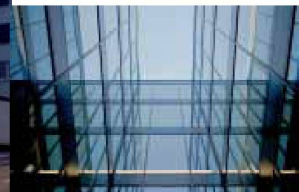
Hartmann setzt visionäre Architektur um: Fassadenbau
