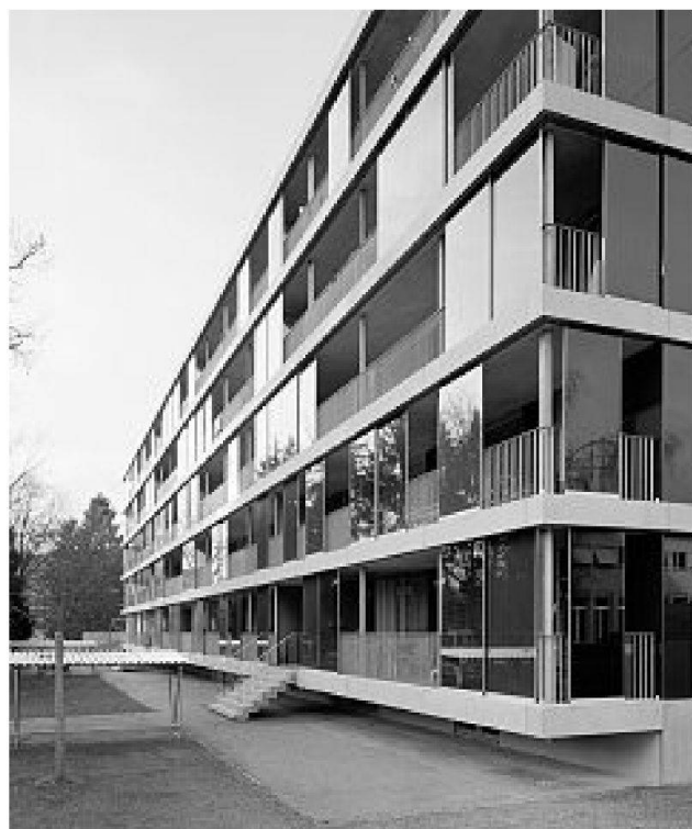
Parkseite, verschiebbare Glaselemente
