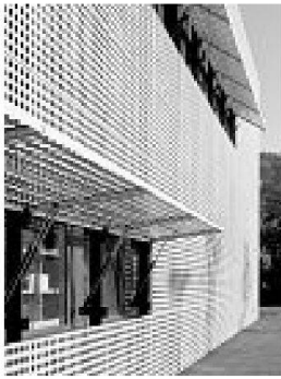
Klappläden an der Fassade
