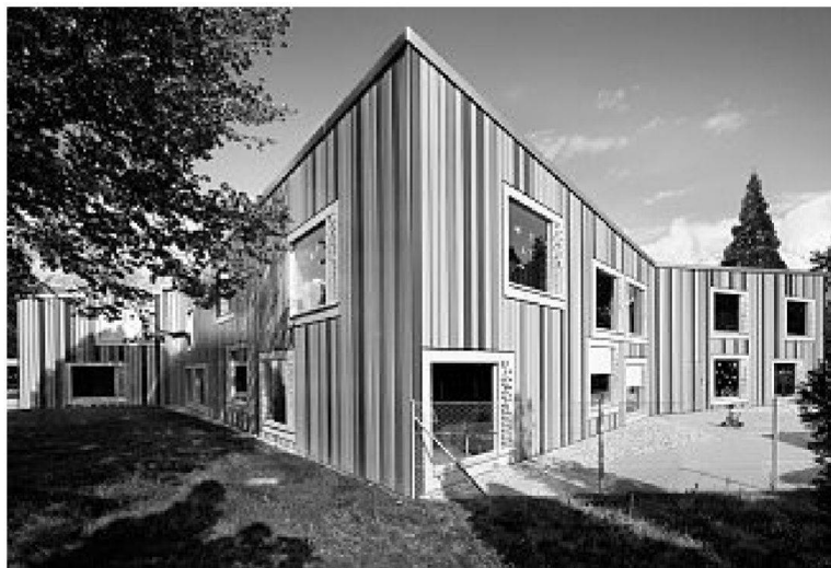
Garderie et parc
