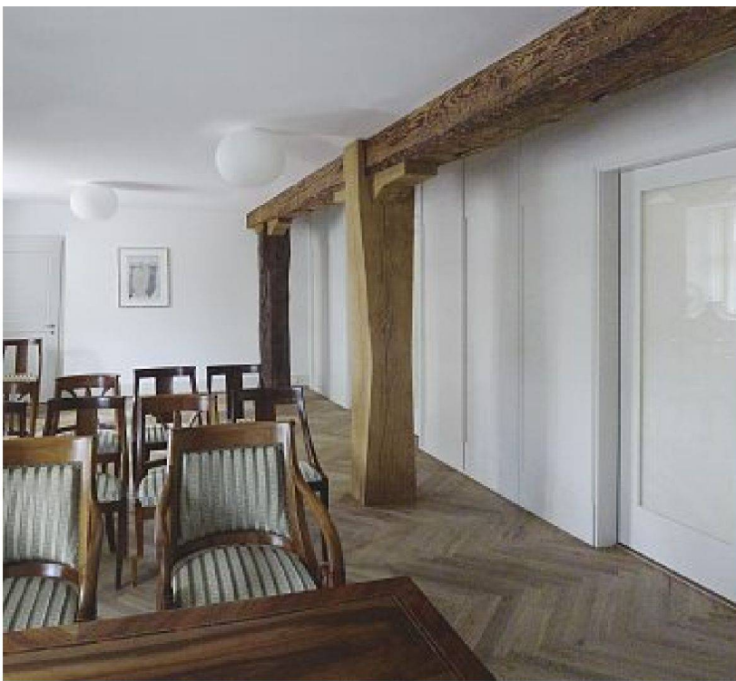
Neue, massive Eichenstützen im Erdgeschoss
