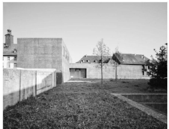
Zugang vom Kasemenareal
