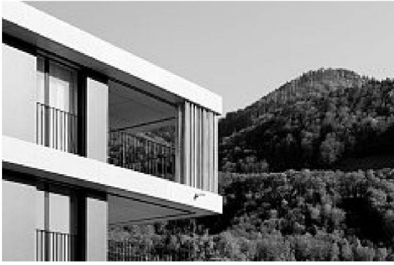
Gebäudedecke mit gewelltem Aluminium-Element
