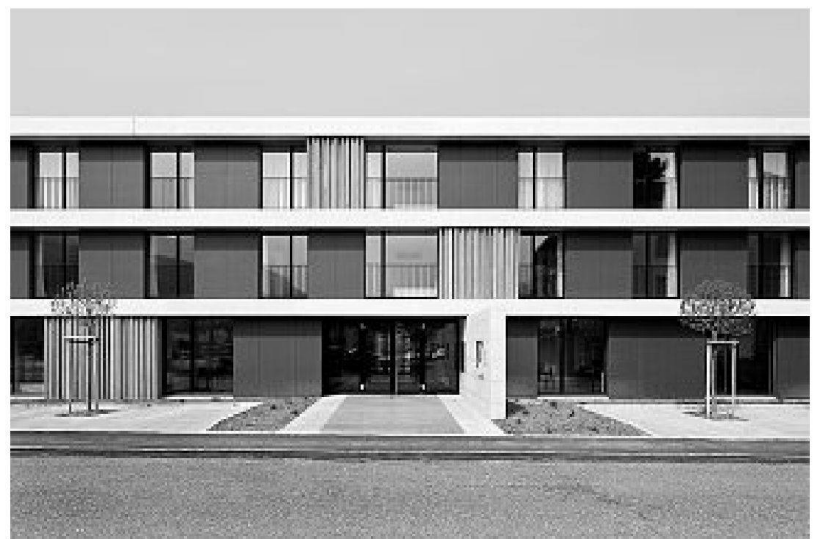
Blick auf den Haupteingang an der Längsfassade
