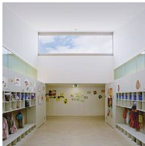
Shedöffnung in der Mitte des tiefen Grundrisses
