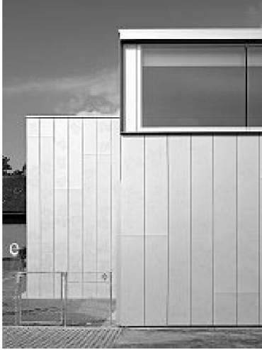
vue du côté est
