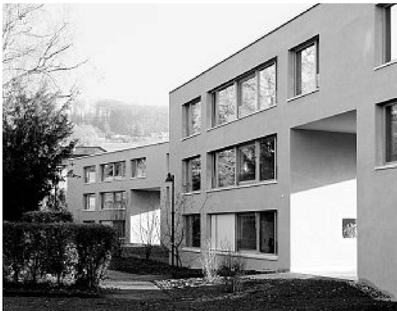
Hangseitige Fassade mit Terrassen
