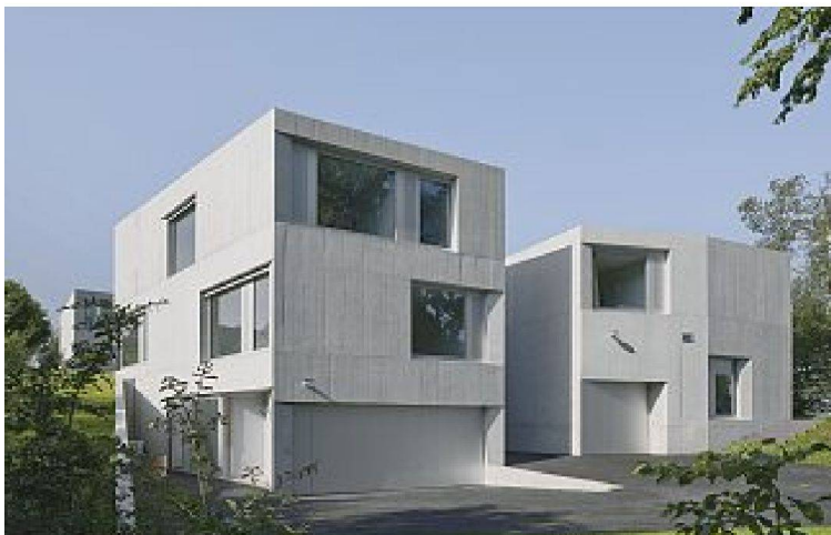
Das grösste Haus der Überbauung und sein «Stöckli» (links); Blick in die gemeinsamen Grünräume zwischen den Betonkörpern (rechts)
