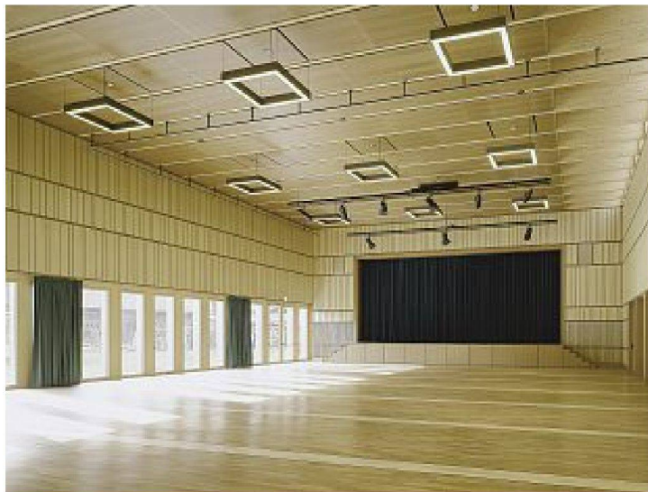
Gemeindesaal mit in der Höhe verstellbaren Deckenleuchten
