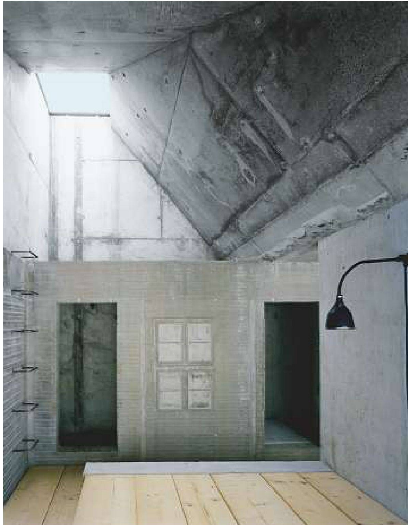
Eisenbügel als Aufgang zu einem Schlafplatz in der Schutzhütte. – Bild: Hans Christian Schink
