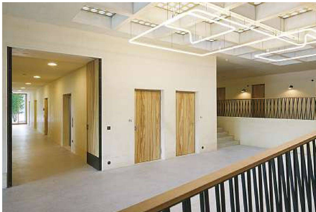
Die Eingangshalle auf dem unteren Niveau des Neubaus erhält Tageslicht über eine Glasbausteindecke.
