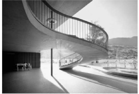
Treppe vom Nichtschwimmerbecken ins Obergeschoss
