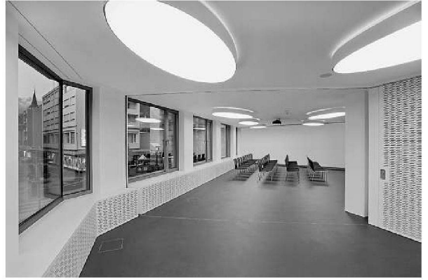
Unterteilbare Konferenzräume im 1. OG
