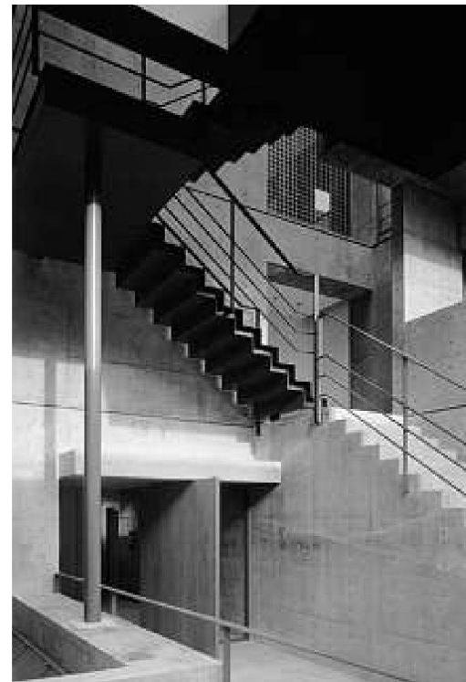
Offenes Treppenhaus und Zugang zum Autohaus. Bild: © Hisao Suzuki
