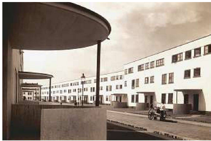
Siedlung Bruchfeldstrasse in Frankfurt, 1927
