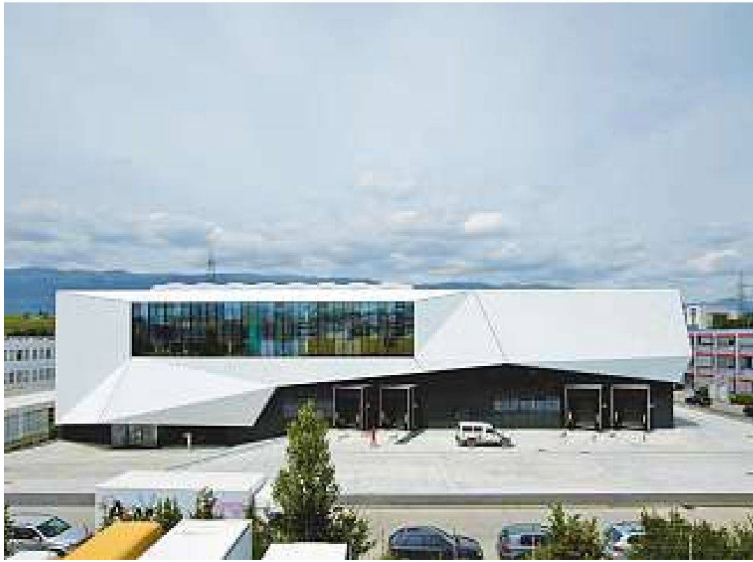
Eine weisse LKW-Plane umhüllt das Logistikzentrum
