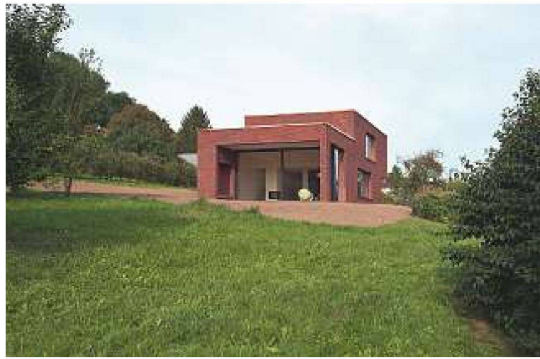
Westseite mit überdachtem Vorplatz
