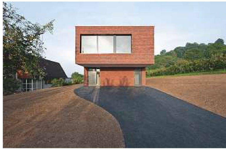
Zufahrt mit Eingangsseite im Osten
