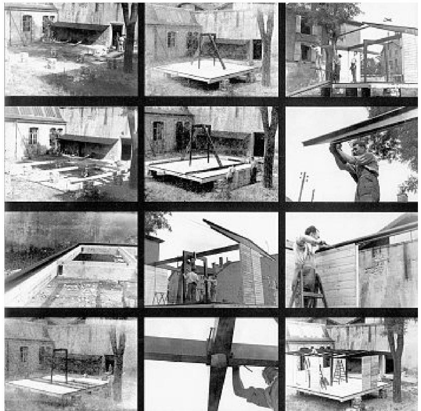
Jean Prouvé: Montage des Prototypen eines Hauses 6 x 6 für Kriegsgeschädigte, 1944–45 auf dem Gelände der Werkstatt in der Rue des Jardiniers in Nancy. – Bild aus: A. von Vegesack (Hrsg.), Jean Prouvé, Die Poetik des technischen Objekts, Vitra Design Stiftung, Weil am Rhein 2006.
