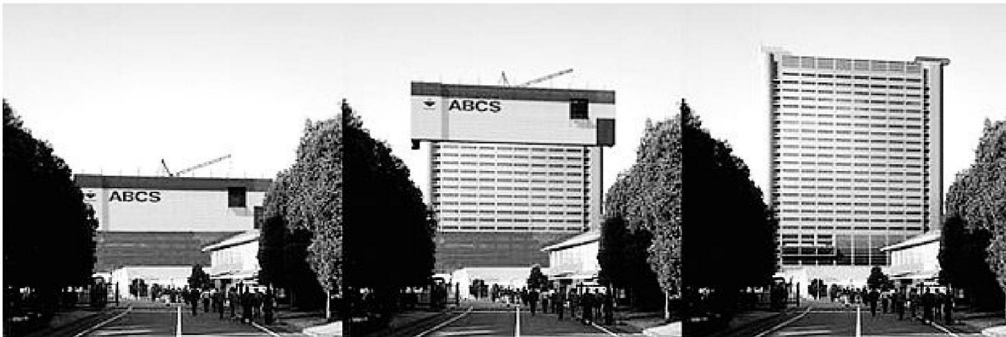
Automatisierte Baustelle in Japan, Bauverlauf der ABCS (Automated Building Construction Systems). – Bild aus: M. Eidenbenz, P. Filipaj und S. Menz (Hrsg.), Changes , VDF Hochschulverlag, Zürich 2010.
