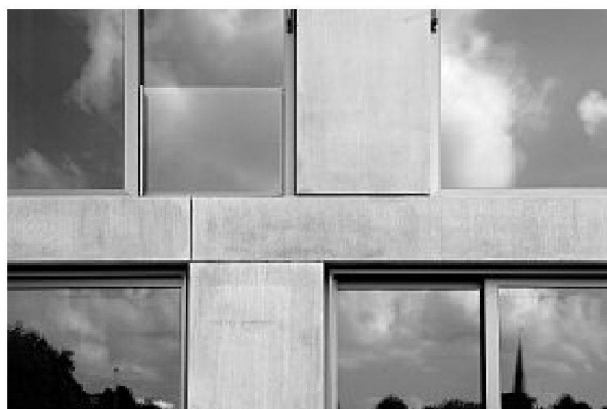
Vorfabrizierte Fassadenelemente aus Beton
