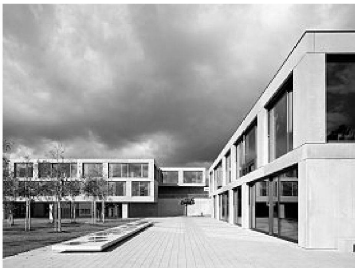
Blick vom Betreuungshaus auf den neuen Schultrakt B
