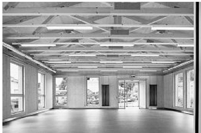
Verkaufsraum mit Nagelplattenbindern
