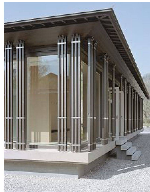
Holzlamellen als Sicht- und Sonnenschutz
