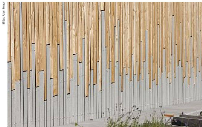
Faserzementplatten und Lärchenholzplatten am Sockelübergang
