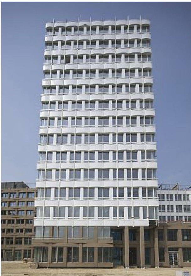
Agfa-Hochhaus, Sockelfassade aus ineinandergefügten Betonfertigteilen, darüber Metallfassade
