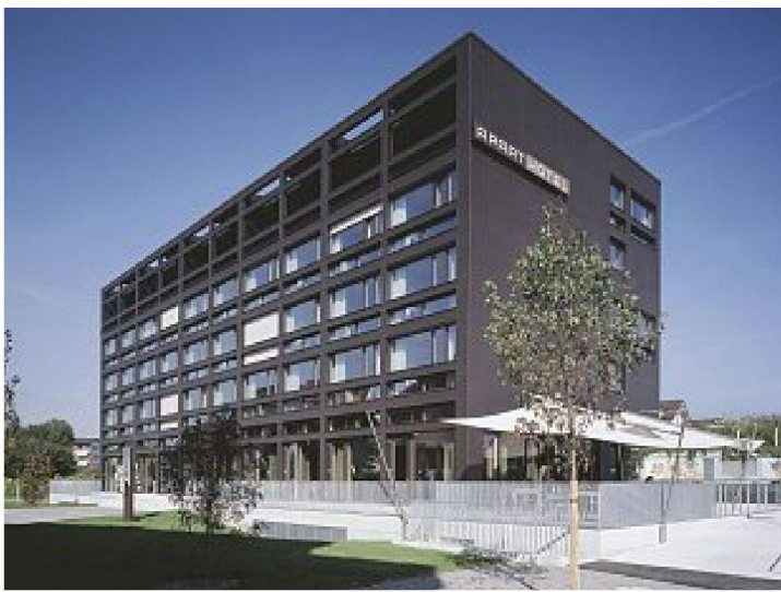
Modernistische Formensprache hinter Eternit-Rundschindeln
