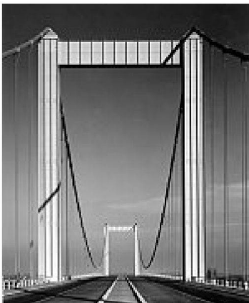
Hängebrücke bei Köln-Rodenkirchen, 1939–41
