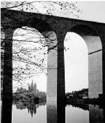
Reichsautobahnbrücke bei Limburg, 1938–40
