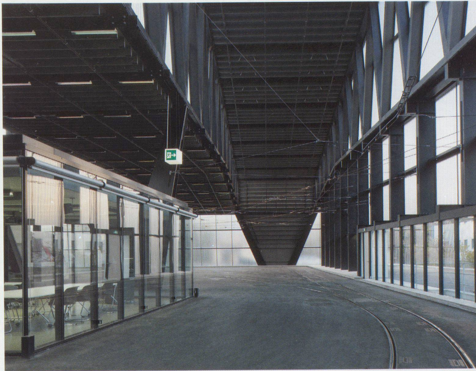
Wendeschleife im hinteren Teil des Depots; bei einer Erweiterung der Werkstatt fällt die Fassade rechts weg.
