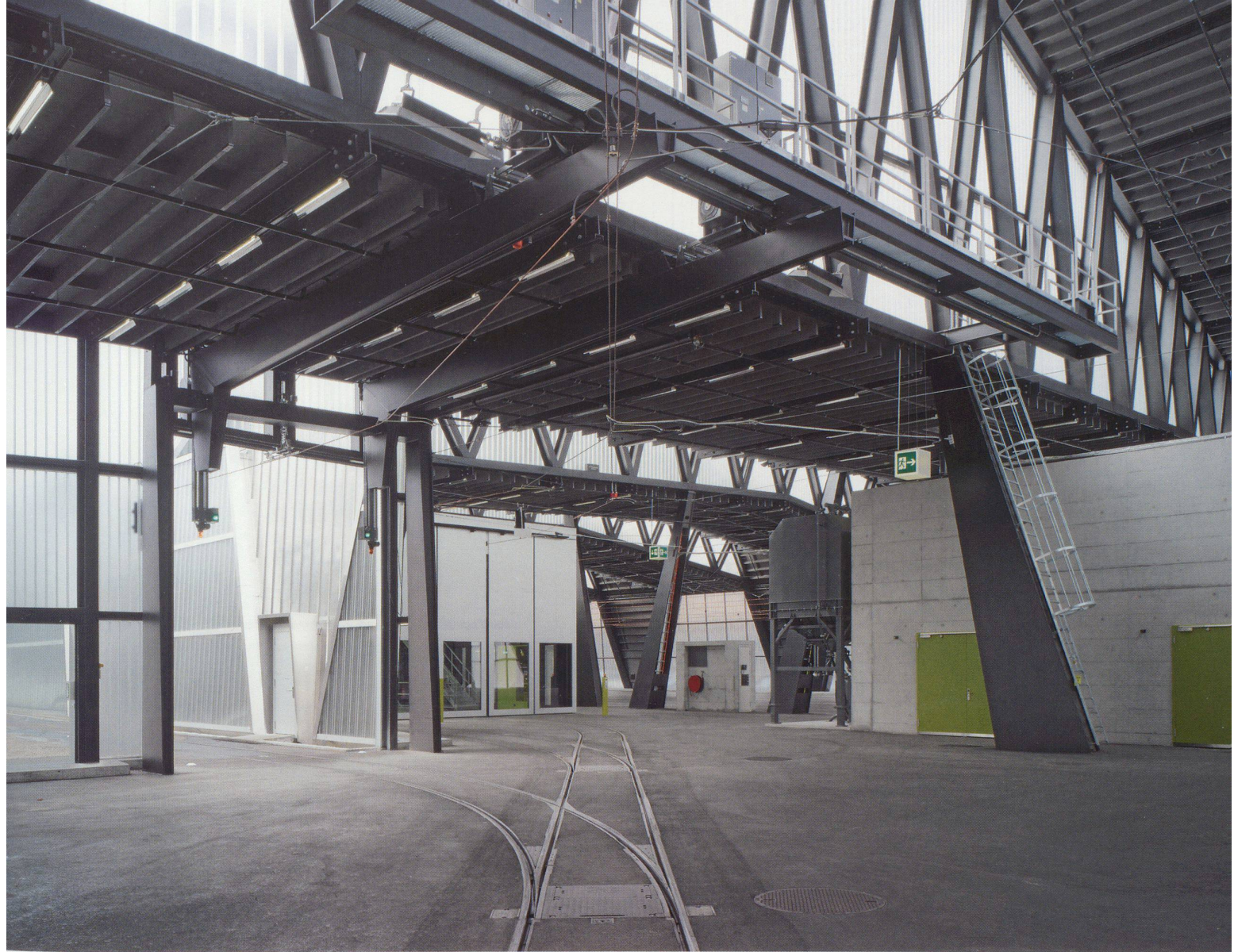
Räumlich-konstruktiver Knotenpunkt: Blick von der Wendeschleife diagonal durch den Wartungsbereich in die Abstellhalle im Hintergrund
