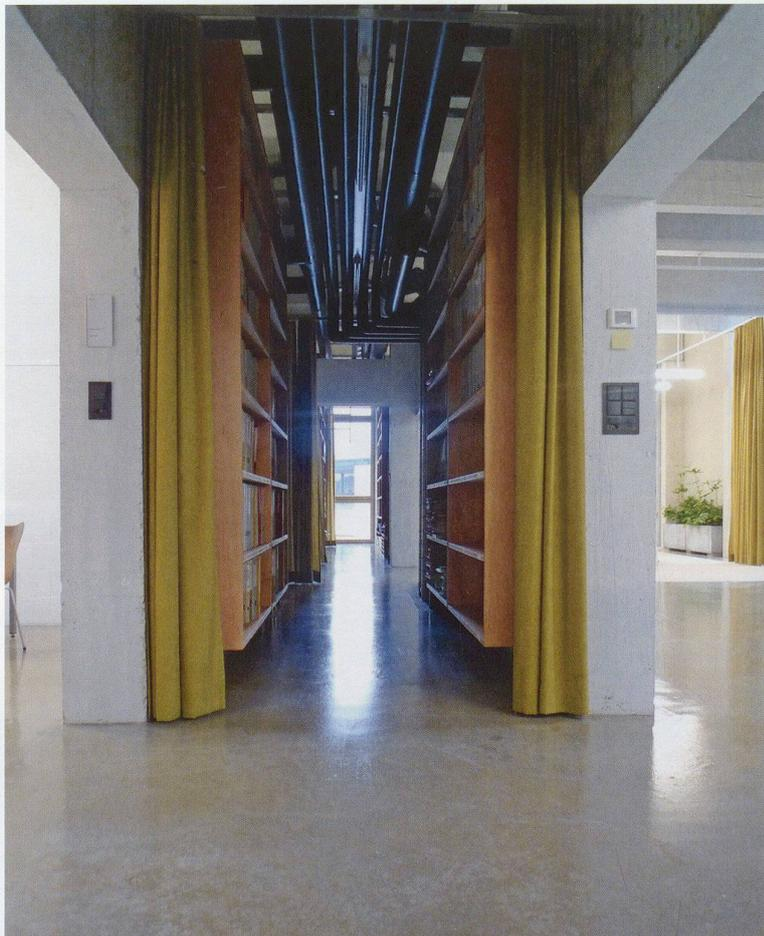
hohen Längsträger und schalungsglatte Beton für die industriell gefertigten Decken- und Fassadenelemente. Der Fussboden ist ebenfalls roh belassen, man sieht die nackte Bodenplatte, nass in nass abtalschiert und hochglanzlackiert. So bestehen die Räume vorwiegend aus denjenigen Materialien und Elementen, die auch draussen im Werkhof gelagert respektive gestapelt sind.
