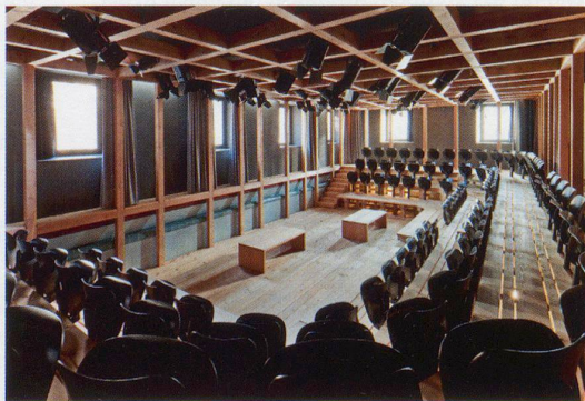
Lärchenholzgerüst als Theater-Einbau im ehemaligen Schwimmbad (rechts), Estrade als mögliche Erweiterung des Bühnenraums (links) und Foyer mit inszenierten Rohrleitungen (unten)
