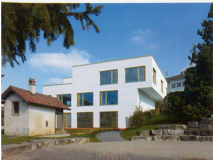
Espace pour enfants in Attalens: Westfassade und Kinderkrippenraum im Gartengeschoss
