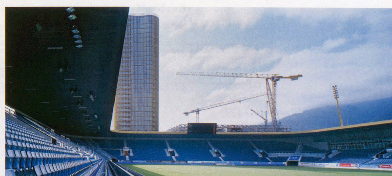
Stadion Luzern: Die Ränge sind in dunkelblau gehalten, was sich mit der dunkelblauen Decke der Gänge verbindet. Die Architektur ist ein Beispiel für die Integration von Wohn- und Geschäftszwecken in ein bestehendes Stadion.
