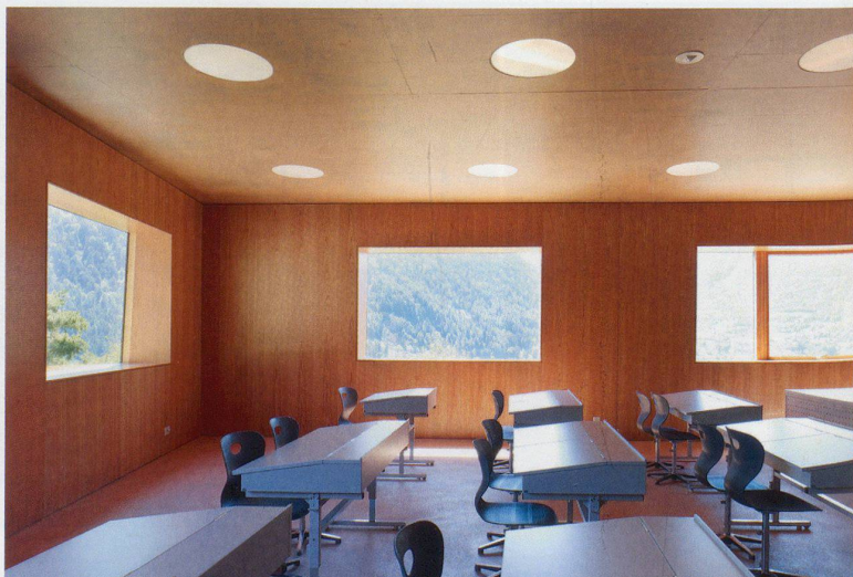
Übereck orientiertes Klassenzimmer mit Lärchenholz-Auskleidung
