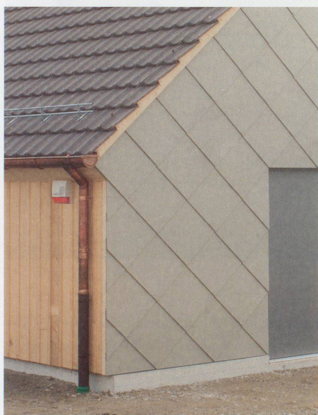
Giebelseite: übergrosse Eternitplatten, Traufseite: Holz
