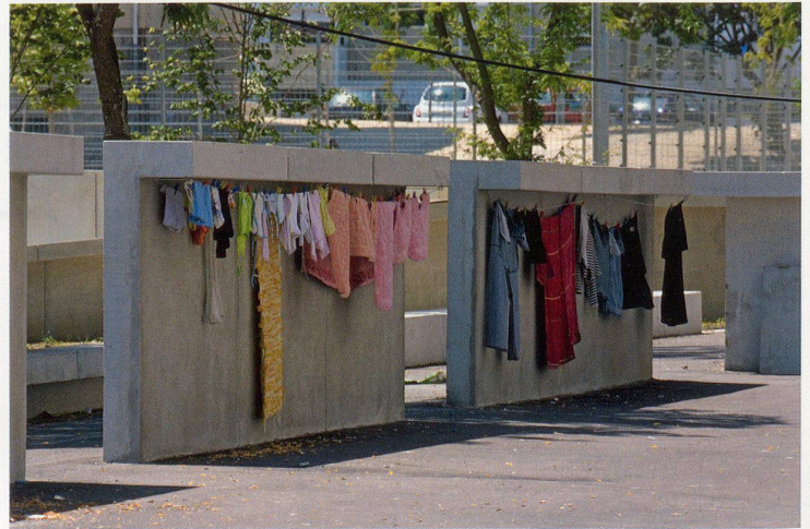
Vereinheitlichung des Aussenraums mit Betonelementen (oben); spontane Aneignung der frei stehenden Betonelemente (unten)
