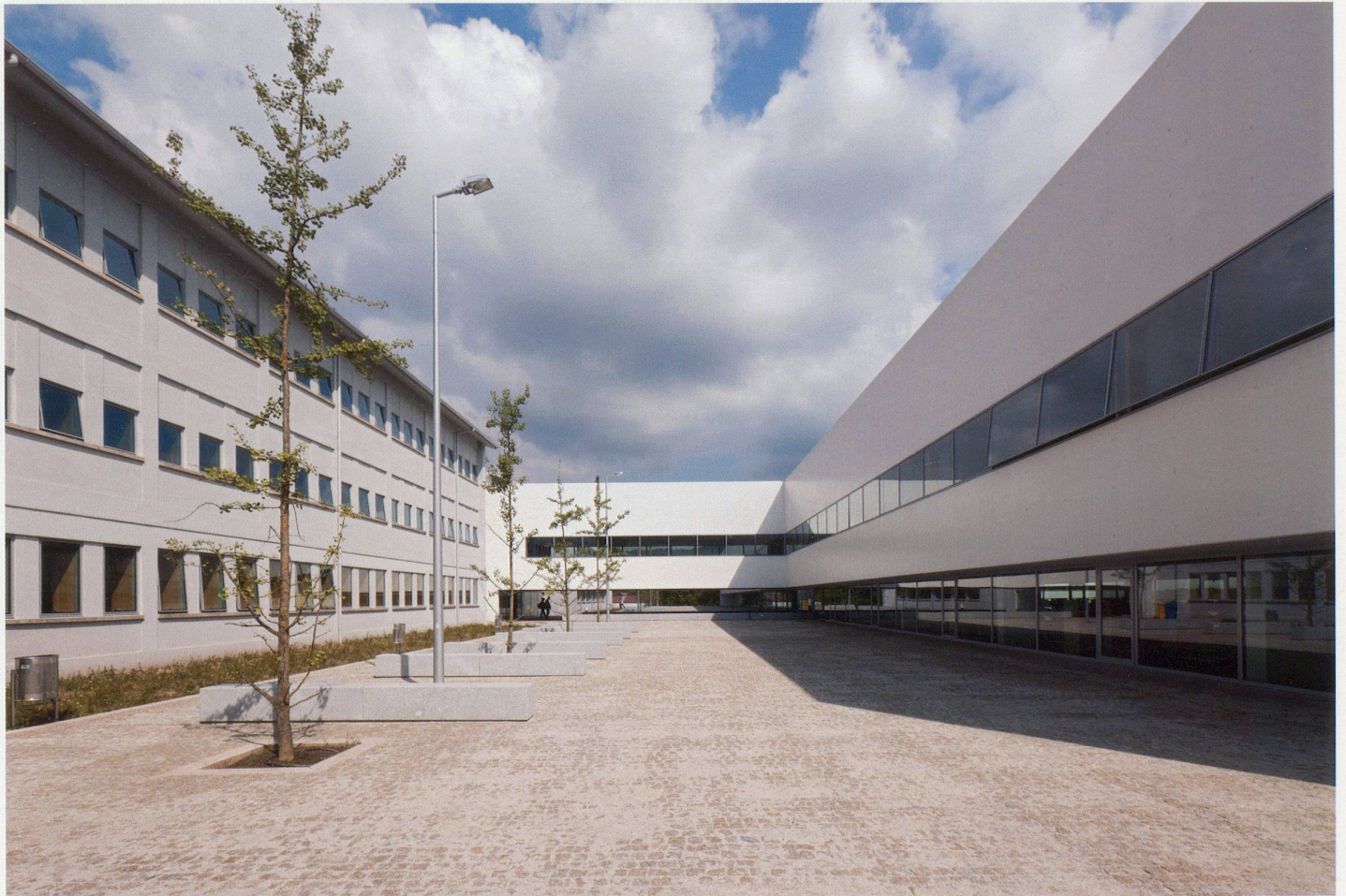
Neuer Eingang zur Strasse (oben links); Speisesaal (oben rechts); Pausenhof zwischen Alt- und Neubau
