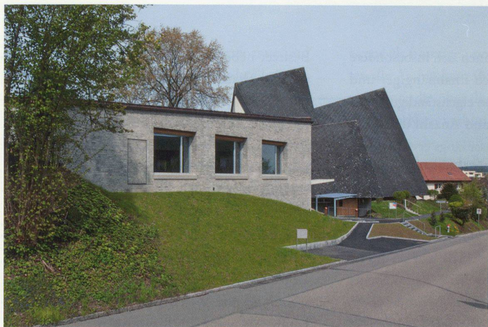
Neubau vor der katholischen Kirche Dielsdorf
