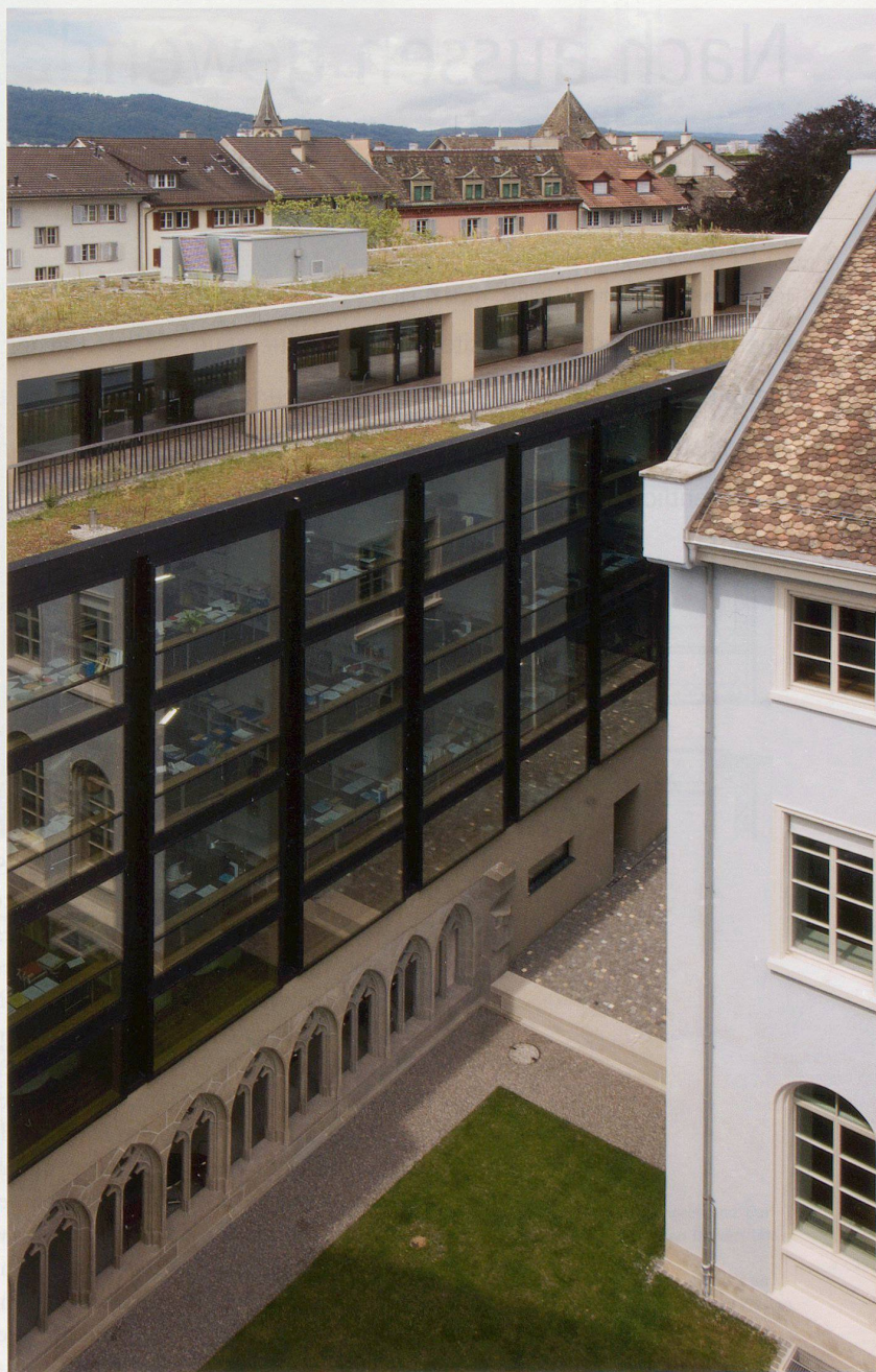
Hofseitige Glasfassade des Ergänzungsbaus
