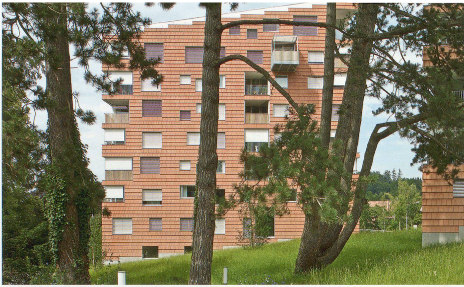
Punkthäuser am Grünraum mit alten Bäumen (links); Zenitallicht im zentralen Treppenhaus (rechts)
