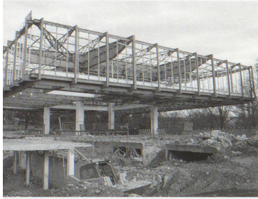
Rückbau bis zum Skelett
