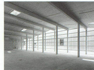
Halle froide avec simple peau en polycarbonate
