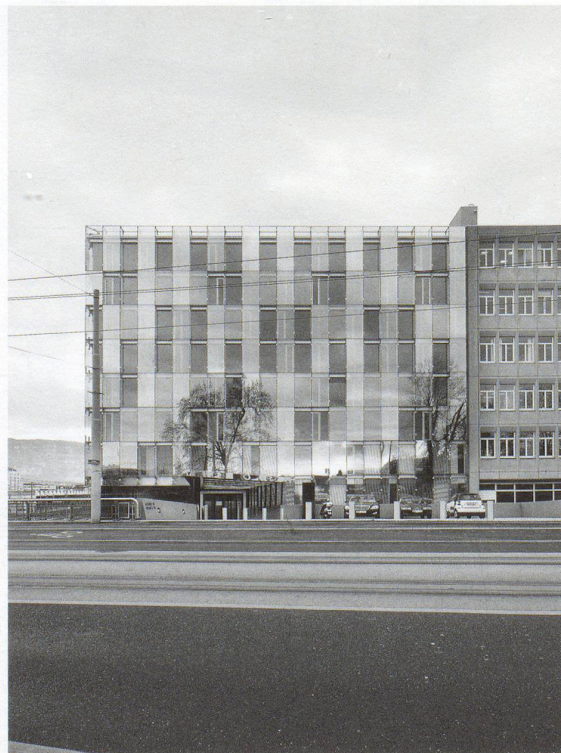
Façade donnant sur l'Avenue de France
