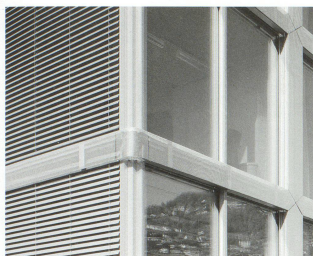
Détail de la façade
