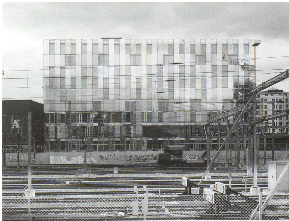
Façade orientée vers les voies de chemin de fer
