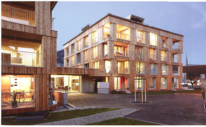
Ansicht von Süden auf den Zwischentrakt mit zentralem Eingangsbereich
