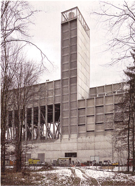
Maschine und Wahrzeichen in einem: Die neue Energiezentrale Bern von Graber Pulver Architekten. Bild: Georg Aerni
