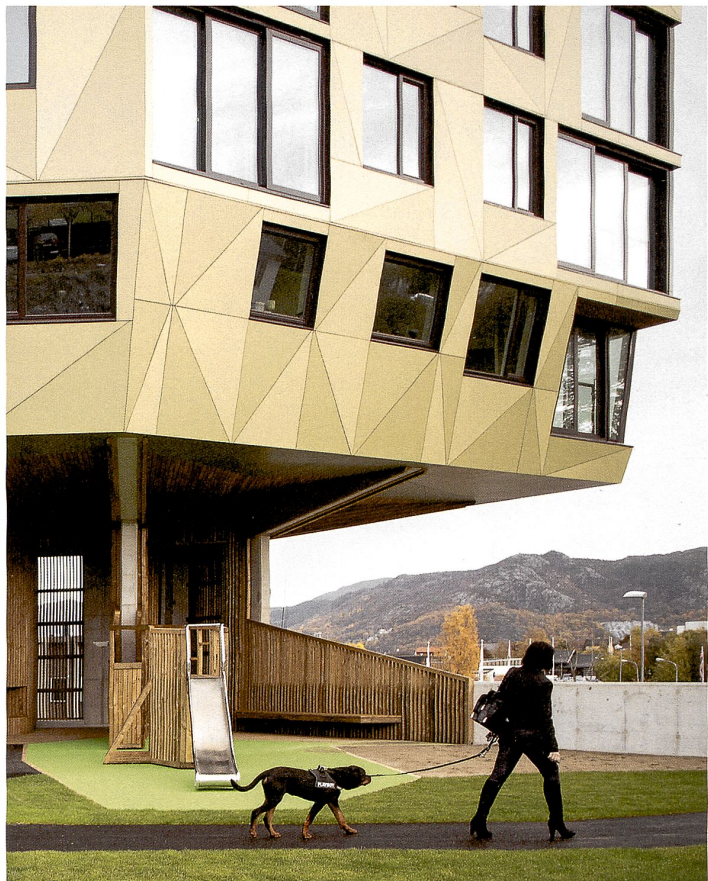
Das Sockelgeschoss als offener Wohn- raum mit Spielgeräten und Sitzgelegenheiten. Bild: Alex de Rijke, dRMM architects
