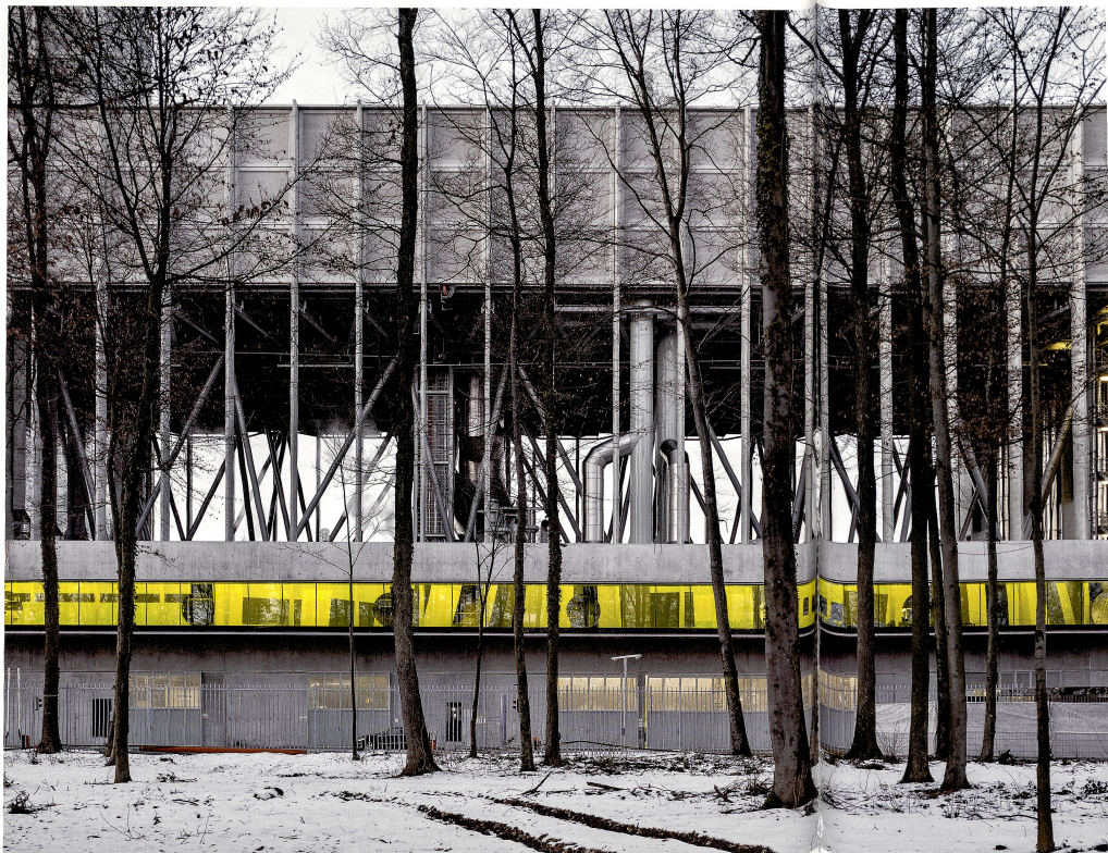
Maschine im Wald: Der Baukörper der Energiezentrale liegt in einer gerodeten Lichtung. Fassade und Konstruktion der Grossform sind in ein modulares System von Betonelementen aufgelöst.
