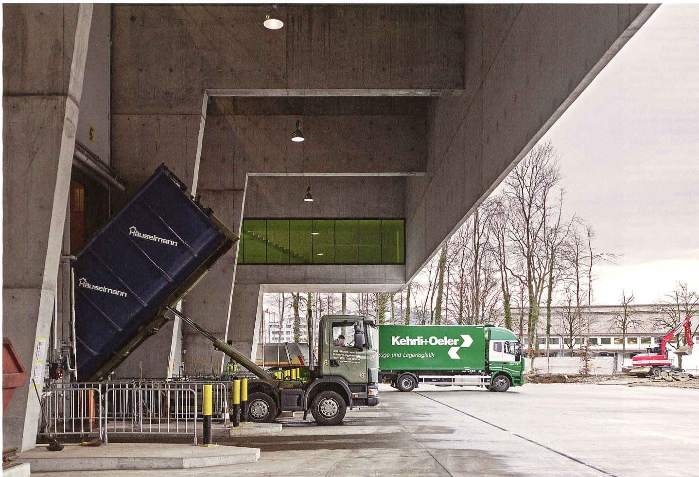
Über dem Kehricht-Anlieferungsbereich wird das massive Volumen zu einer filigran wirkenden Komposition von statisch wirksamen Scheiben und Schürzen aus Beton.
