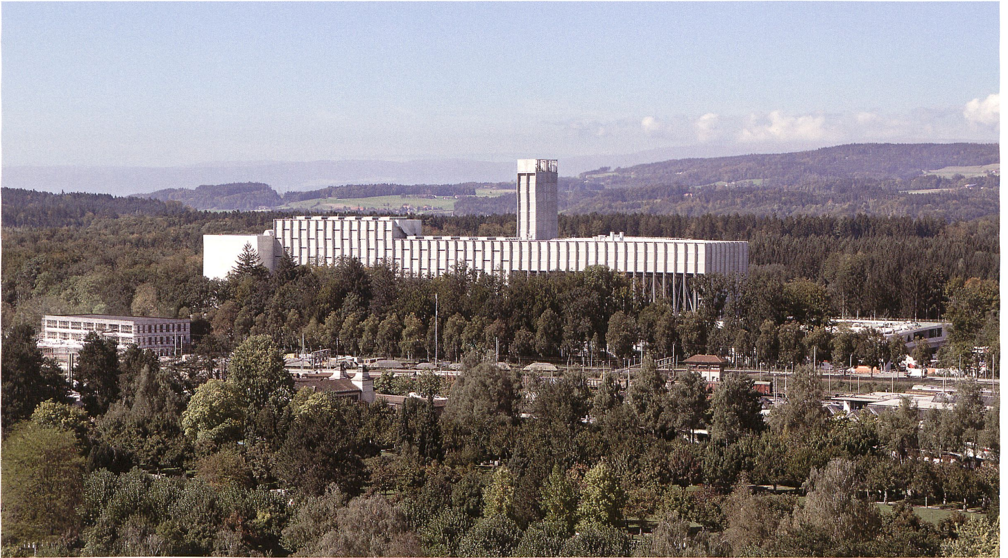
Kathedrale des Recyclingzeitalters: Der Bau von der Ausdehnung einer Altstadtgasse markiert die heutige Bedeutung technischer Netzwerke.
