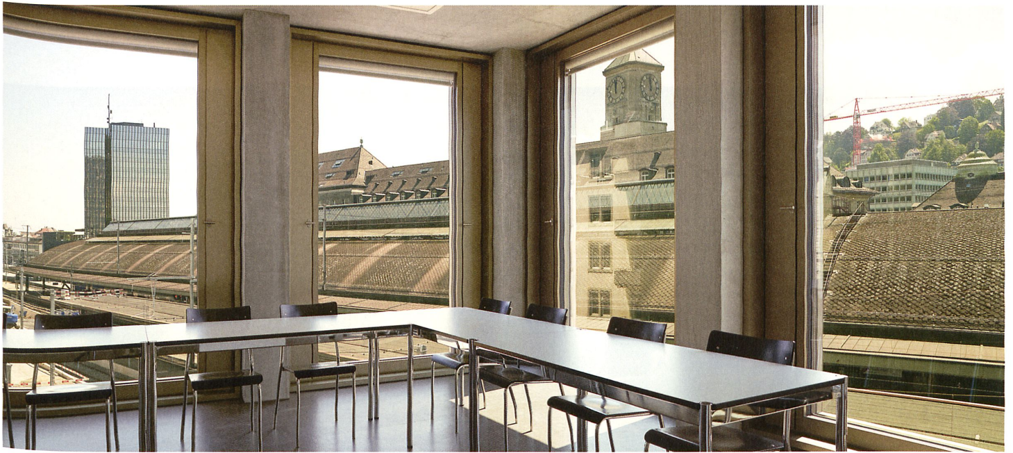
Die Institution wird einsehbar: tragende Pfeiler und von innen angeschlagene Kastenfenster. Bild: Walter Mair
