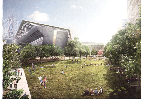
Der erste Auftrag von Cornell Tech wurde an Morphosis vergeben. Die aufwändige Konstruktion des Lehr- und Forschungsbau umgeben von Rasen, soll die Hightech-Uni und deren Anspruch, eine «net zero»-Hochschule zu werden, versinnbildlichen. Bild: Morphosis
