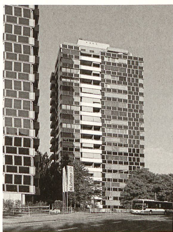
Die Sihlweid-Hochhäuser in Zürich-Leimbach, 2011–2013 von der bürgerlichen Baugenossenschaft Zurlinden umfassend saniert. Bild: Markus Jelk
