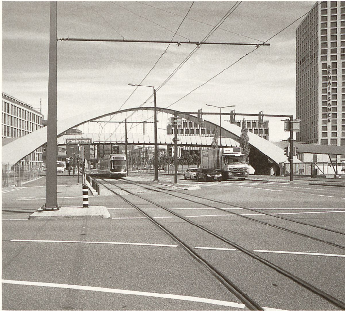
In der Pfingstweidstrasse in Zürich verkehrt das Tram auf Eigentrassee und hat eine massive Verbreiterung dieser Ausfallstrasse ausgelöst, Zäune sperren den Gleisraum ab. Bild: Andrea Helbling.
